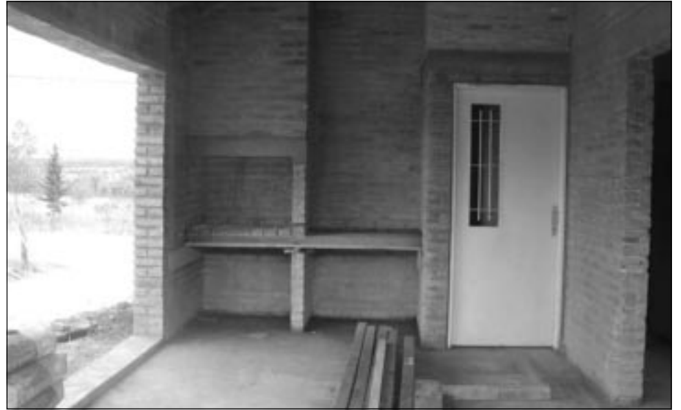
■ Un aspecto de una de las viviendas que se están construyendo en el futuro complejo turístico del gremio mercantil juninense en Mina Clavero, provincia de Córdoba.
