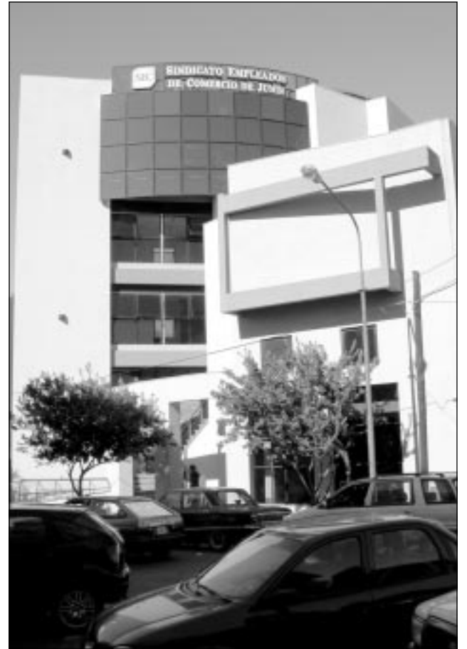
■ Frente del edificio que ocupa el Sindicato de Empleados de Comercio.
